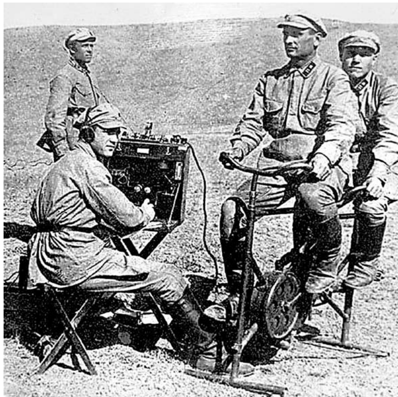
В СССР ещё в 1930-х гг. с помощью динамо-машины вырабатывали энергию для полевых радиостанций.
