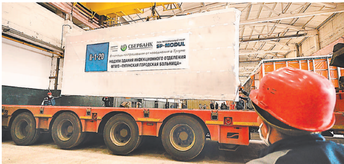
Здание, как конструктор, собирается прямо на строительном участке.
