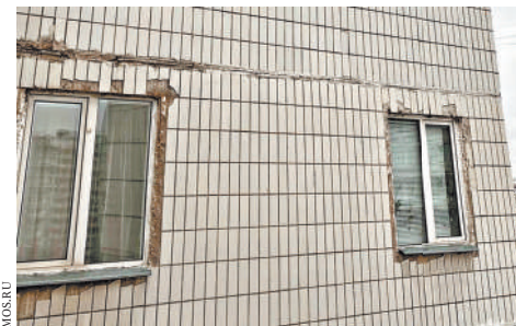
«Лишние окна» вырублены в несущей стене—на такие работы собственник квартиры никогда бы не получил разрешения. Теперь его через суд заставят сделать все, как было.
