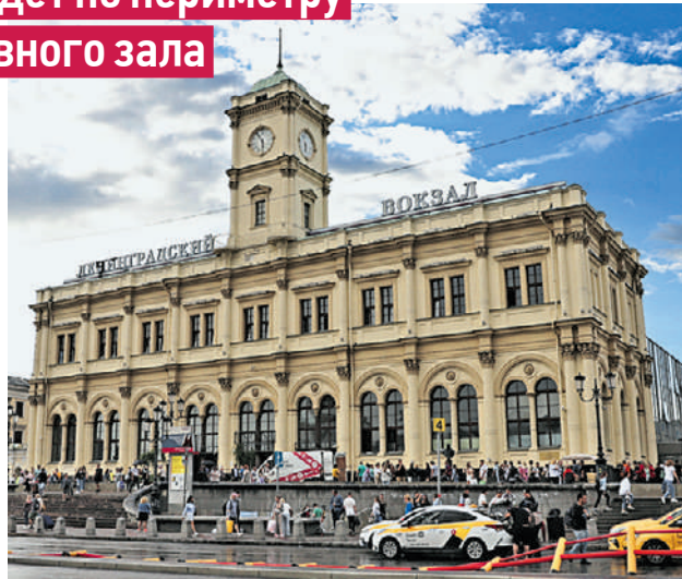
9 августа 2024 года. Здание Ленинградского вокзала перед самым началом реставрационных работ
