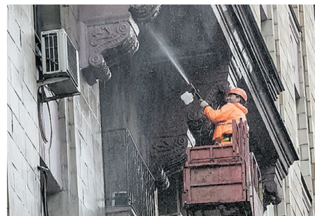
28 марта. Специалист Шероли Мерзаев моет фасад в Тверском районе с помощью автовышки. Фото: Дмитрий Дубинский
