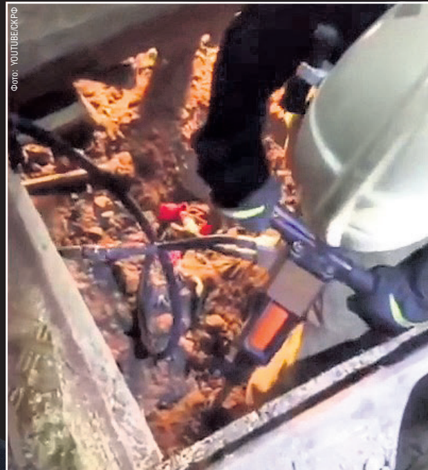
Специстам пришлось отбойными молотками пробивать бетон, чтобы извлечь тело ребёнка
